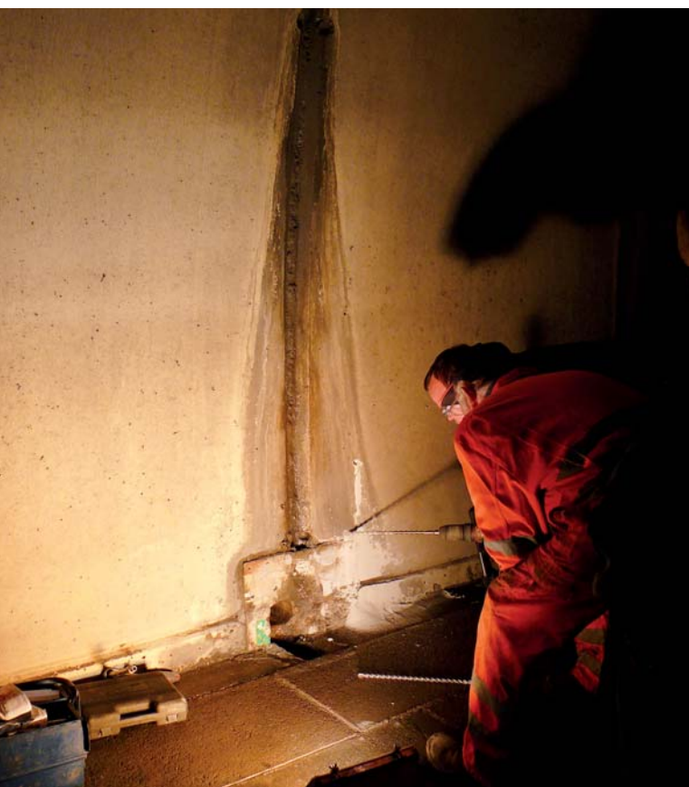
Injektion gegen drückendes Wasser bei der Schleierinjektion
