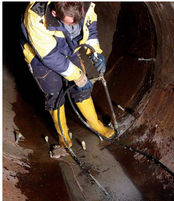
Abdichtung Muffe im begehbaren Kanal
