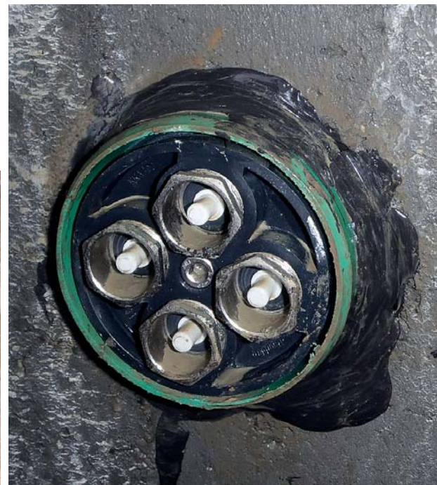
Rohreinbindung in den Schacht >
