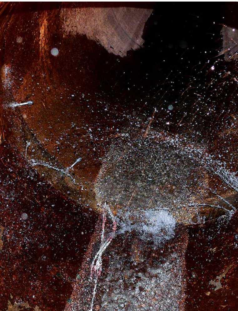
Abdichtung Muffe im begehbaren Kanal
