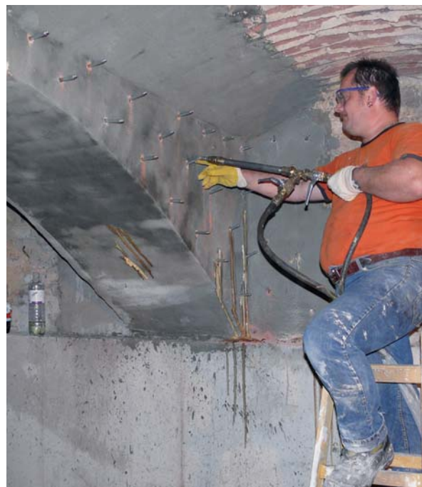
Erhöhung der Tragfähigkeit eines Bogens
