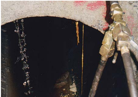
Schachtabdichtung links vor und rechts nach der Injektion
