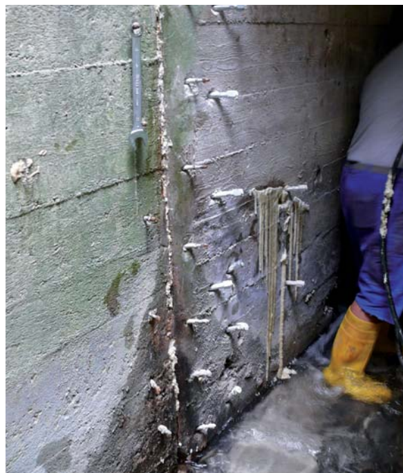
Fuge nach der Abdichtung
