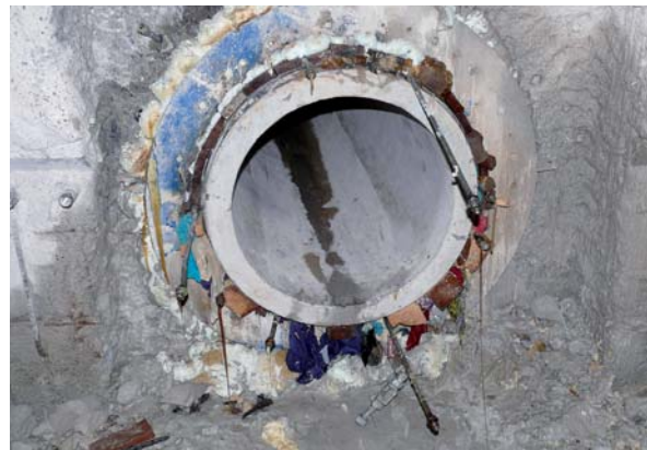
Ringspalt nach der Injektion
