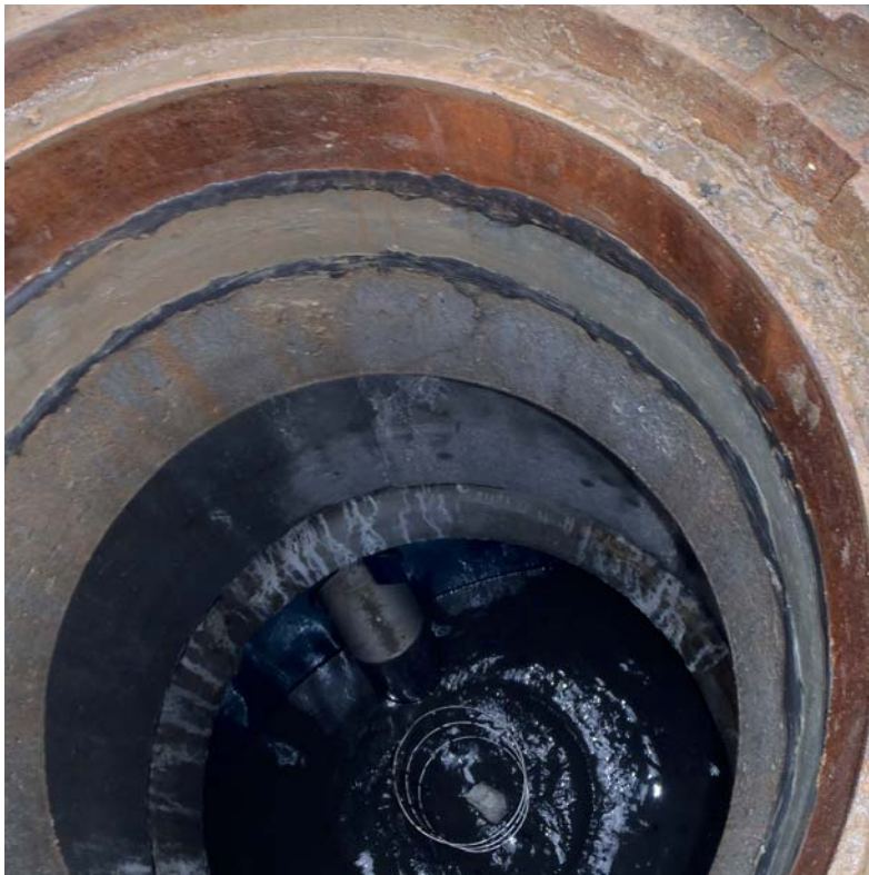
Abdichtung von Schachtringfugen
