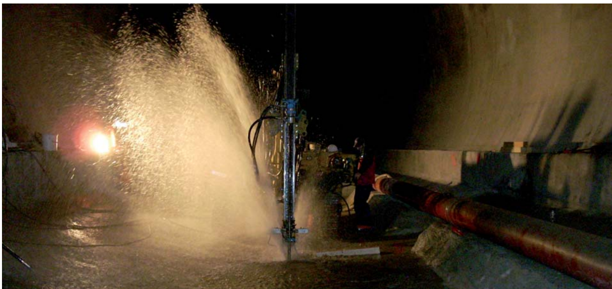
Injektion gegen drückendes Wasser bei der Schleierinjektion
