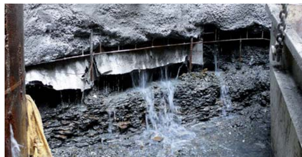
Undichte Spritzbetonschale beim Abteufen eines Schachtes
