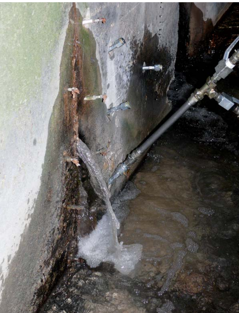
Fuge nach der Abdichtung
