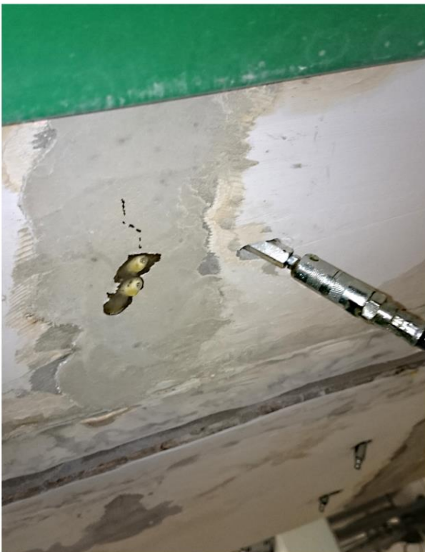
Rissinjektion in einem Sturz
